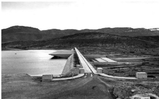
Barrage des BENI-BADHEL
